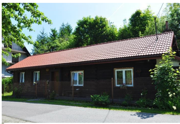
Ryc. 8 Dom przy ul. Krzeszowiaków 25 Fot: Monika Węsjora [stan na rok 2019]
