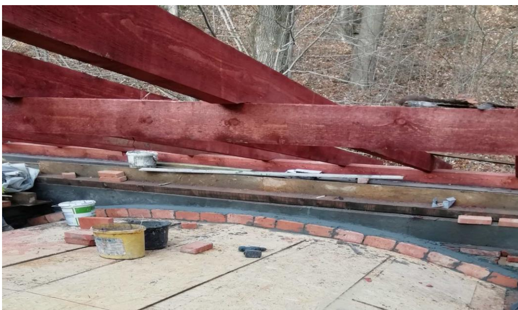
Oranżeria - rekonstrukcja sklepienia
