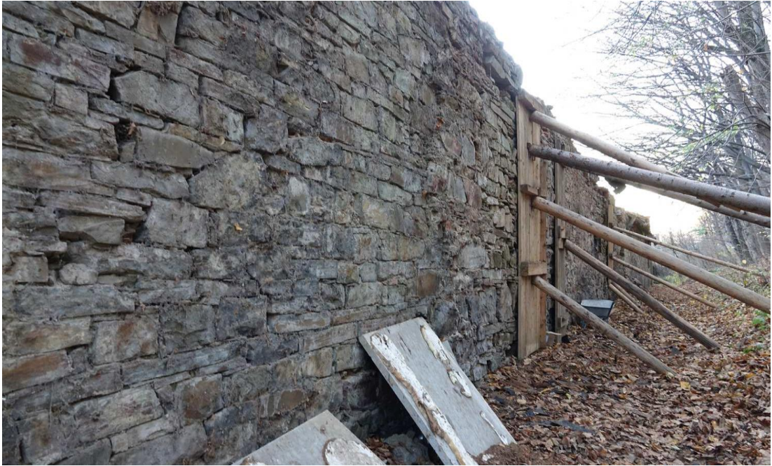
Oranżeria – mur od strony północnej przed jego zabezpieczeniem
