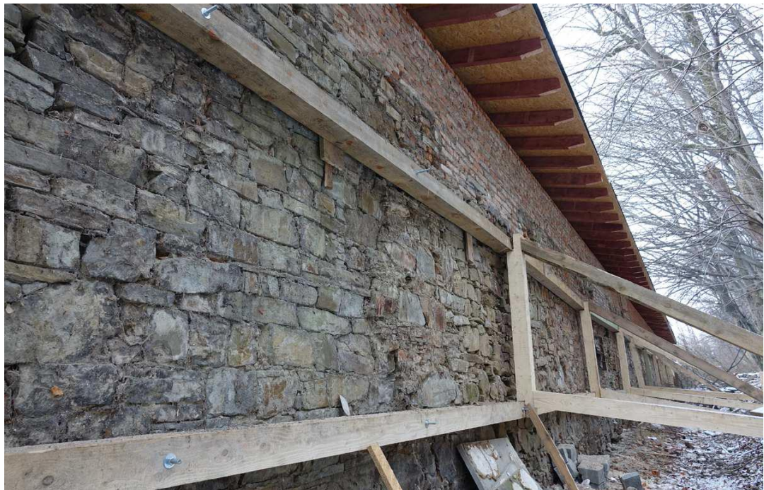
Oranżeria – mur od strony północnej po jego zabezpieczeniu
