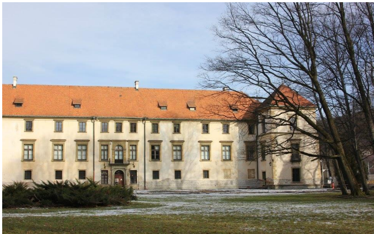
Zamek przed remontem (strona południowa)
