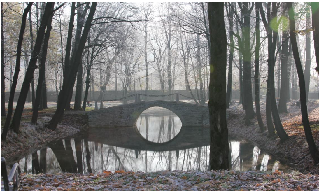
Mostek po remoncie
