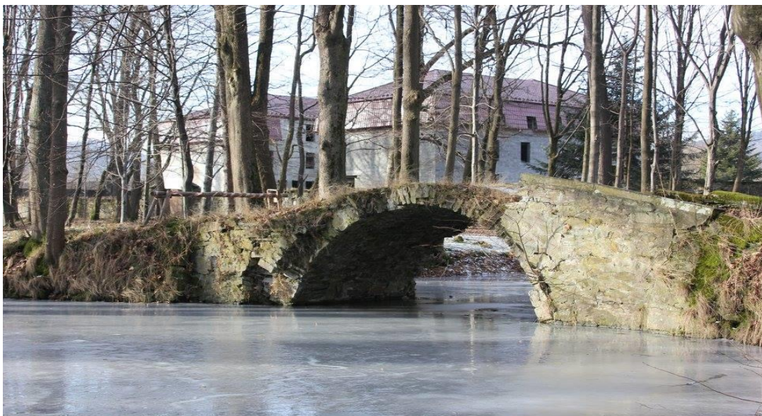
Mostek przed remontem
