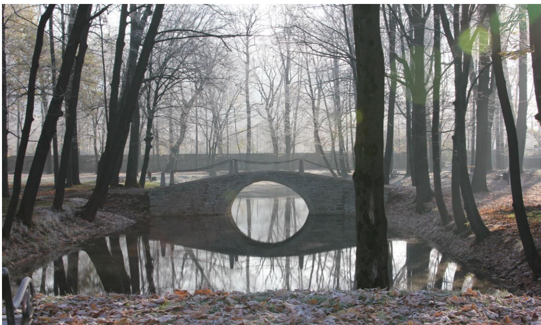
Mostek po remoncie
