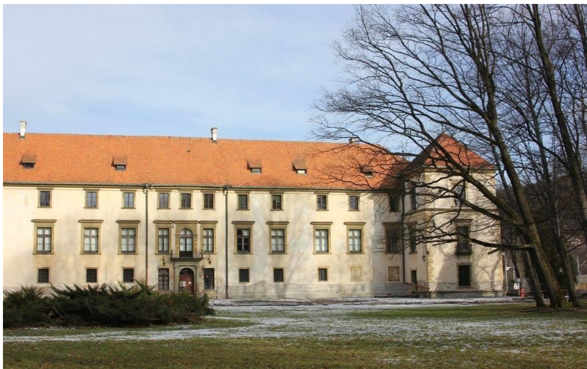
Zamek przed remontem (strona południowa)
