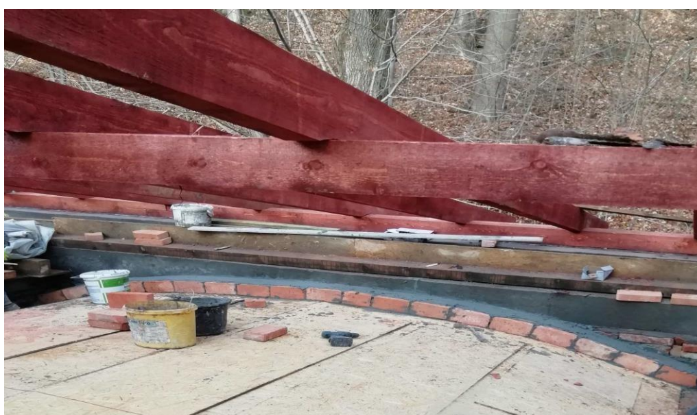
Oranżeria - rekonstrukcja sklepienia
