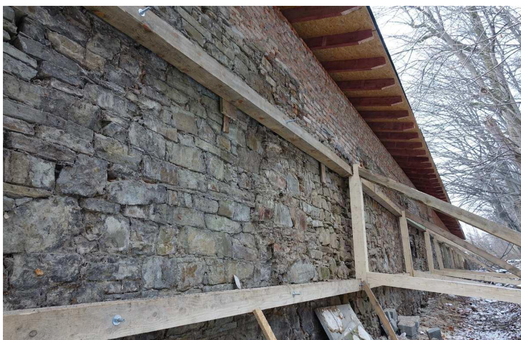
Oranżeria – mur od strony północnej po jego zabezpieczeniu
