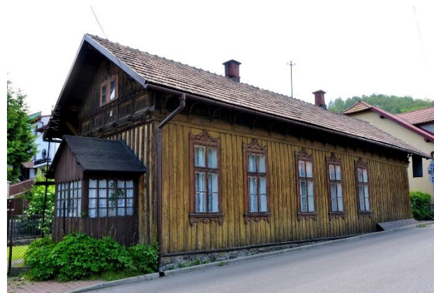
Ryc. 11 Dom przy ul. Zасыpnica 3 Fot: Monika Węsjora [stan na rok 2019]
