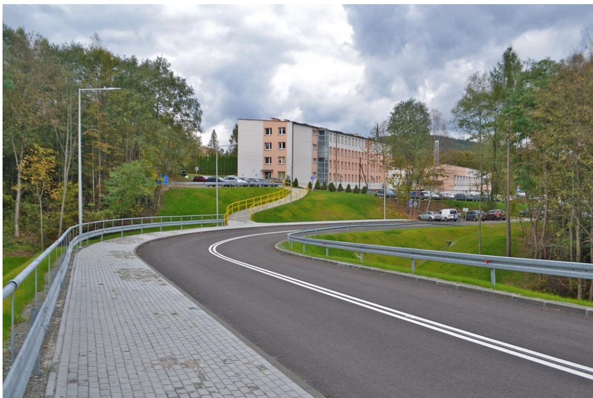
Zdjęcie nr 3. Fragment nowej drogi – łącznik pomiędzy ul. Kościelną , a ul. Szpitalną
