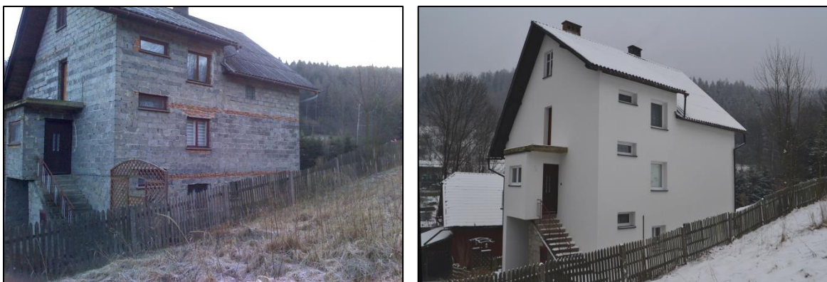
Zdjęcie nr 5. Budynku przy ul. Zasypnica przed i po termomodernizacji.
