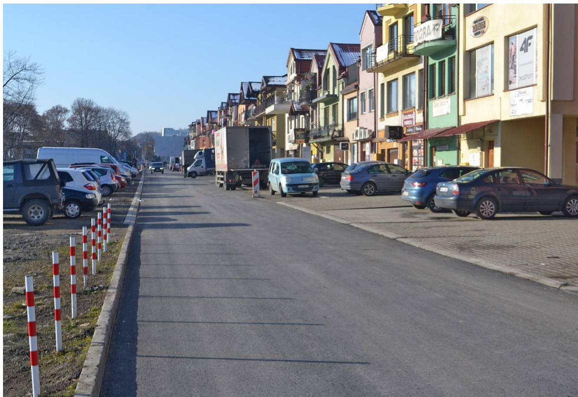
Zdjęcie nr 4. Nowa nawierzchnia drogi – ul. A. Szczepkowskiego w Suchoj Beskidzkiej
