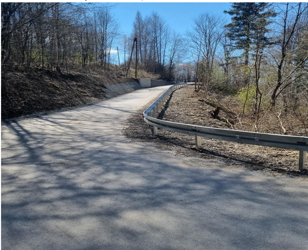
Zdjęcie nr 5. Droga do osiedli Garce - Śpiwle po przeprowadzonej modernizacji
