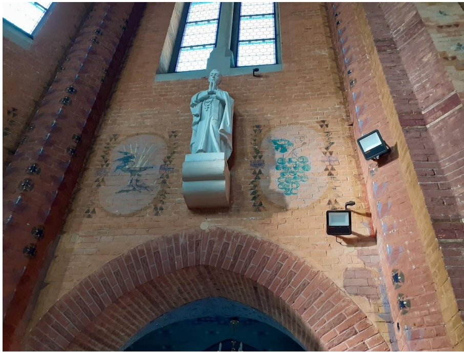
Ściany kościoła po oczyszczeniu, konserwacji i malowaniu
