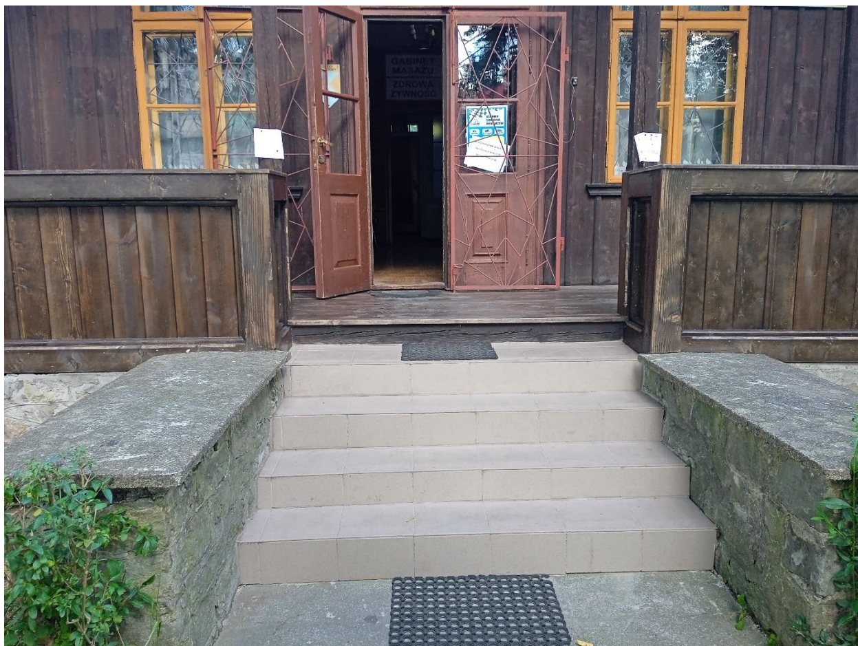
Weranda i schody do budynku po remoncie
