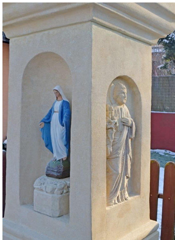
Figura w niszy po renowacji
