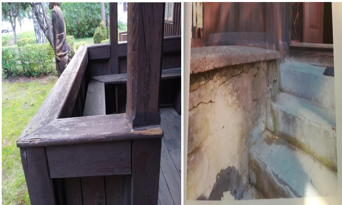
Weranda i schody do budynku przed remontem
