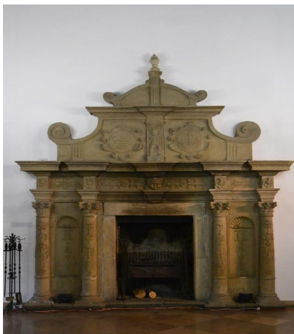
Kominek przed renowacją
