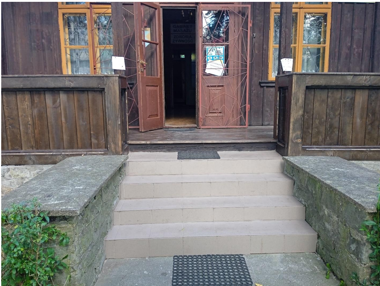
Weranda i schody do budynku po remoncie
