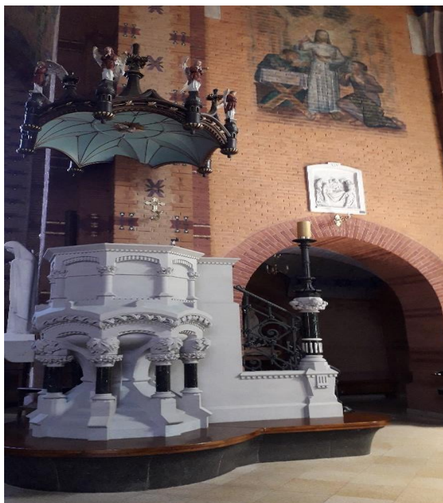
Ambona z baldachimem po konserwacji
