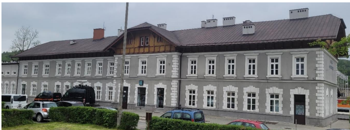
Fot. nr. 11. Zdjęcie z Karty Adresowej Zabytku GEZ do aktualizacji gminnej ewidencji zabytków z 2023 roku, autor Jolanta Sroczyńska.
