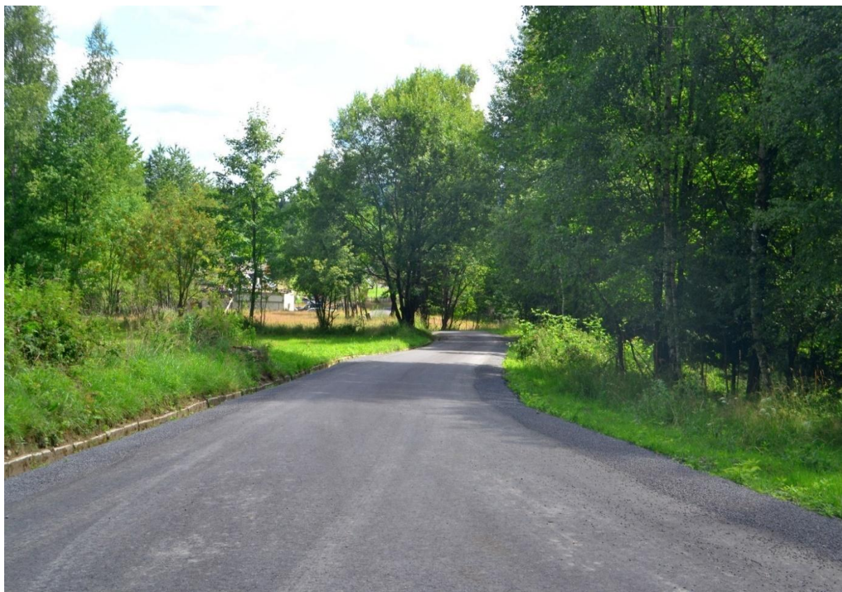
Zdjęcie nr 8. ul. Górská po remoncie
