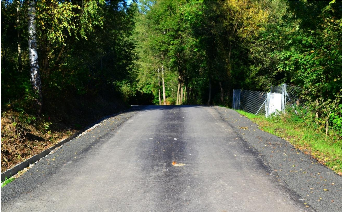
Zdjęcie nr 5. ul. Sosnowa po remoncie
