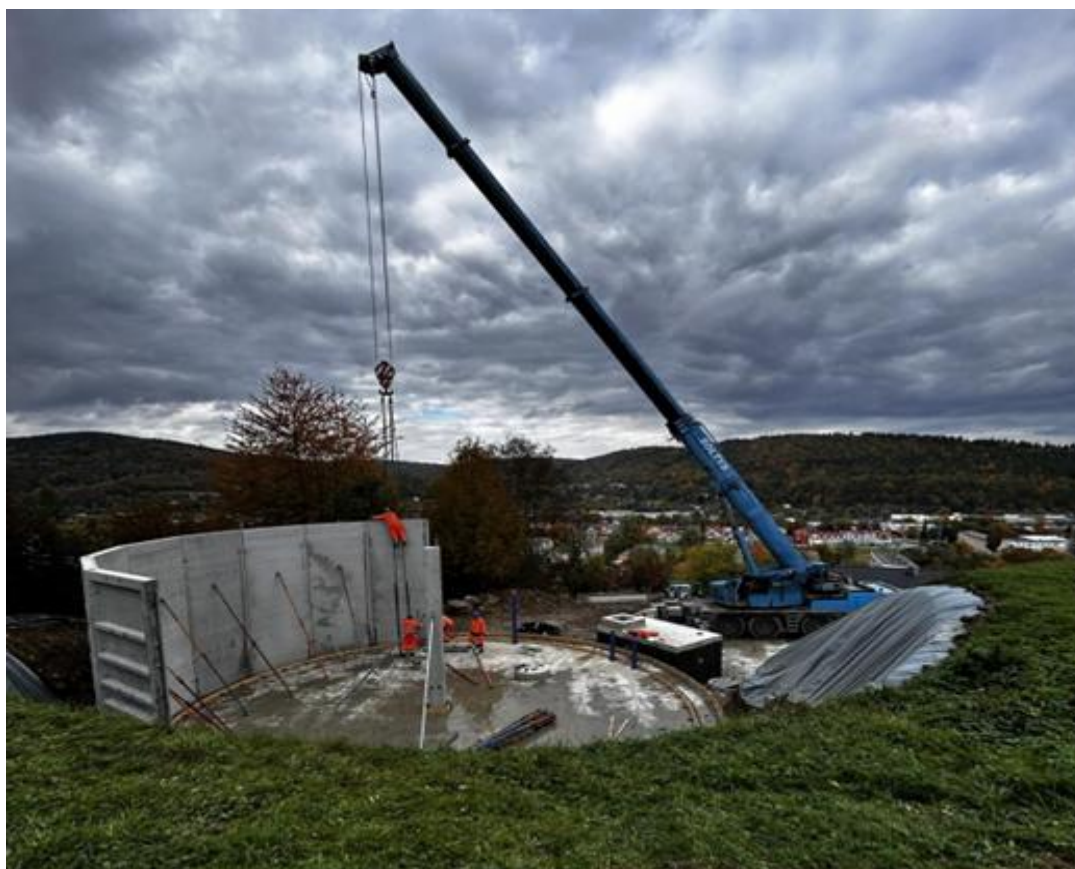
Zdjęcie nr 1. Budowa zbiorników wody pitnej przy ul. Źródlanej
